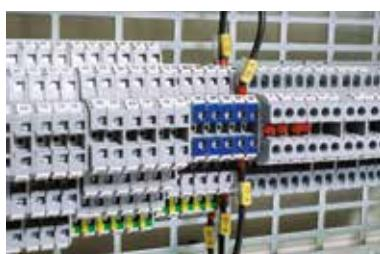
PUK 2T serisi vidalı ray klemensleri aydınlatma ve priz linyelerini içeren kat panolarında, bir linyeye ait faz-nötr-toprak bağlantılarını tek klemenste yapmaya imkan sağlar. Faz ve nötr katları ayrı ayrı köprülenebilir. Topraklama için klemensi raya takmanız yeterlidir. Plotter ile projelerinize uygun markalama çözümleri mevcuttur.
